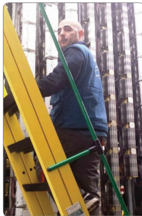
Asier durante la revisión de una instalación.
